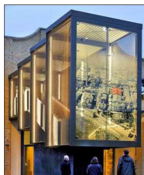
Das neue Treppenhaus in Form einer historischen Plattenkamera gehört zur neuen, lichtdurchfluteten 2. Etage samt Ausstellungsraum in der ehemaligen Begießerei für Filmunterlagen.
